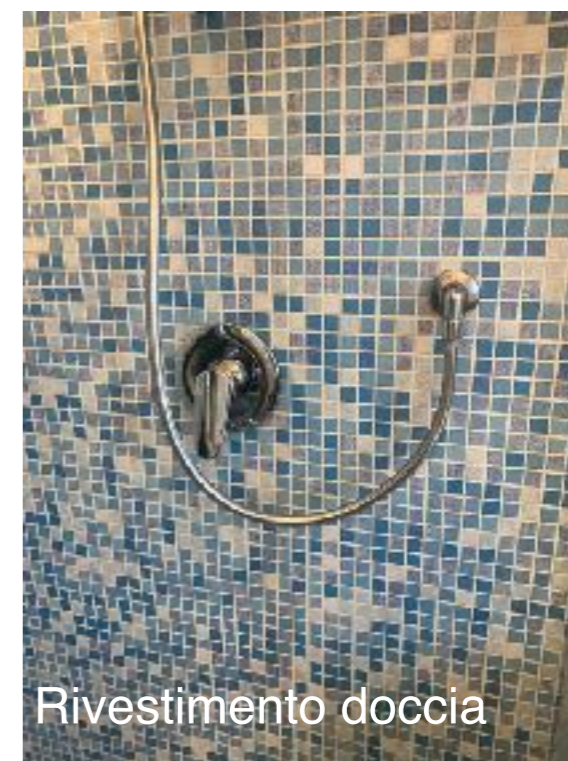
Rivest. bagno principale
